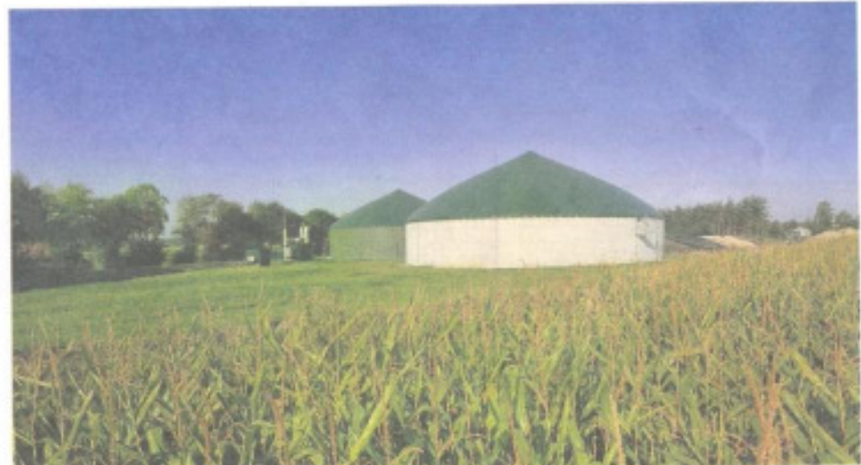
Der Bau von Biogasanlagen bleibt attraktiv. Betreiber und neue Investoren schätzen die sichere Einkommensquelle auf gesetzlicher Grundlage.
